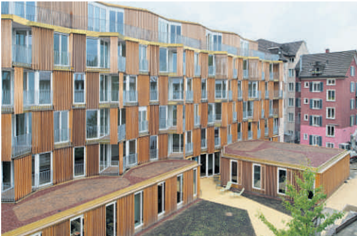
Die grossen Fenster der Siedlung Feldstrasse bieten Au sblick i n den Hof, die Holzlamellen gewähren Privatsphäre.
